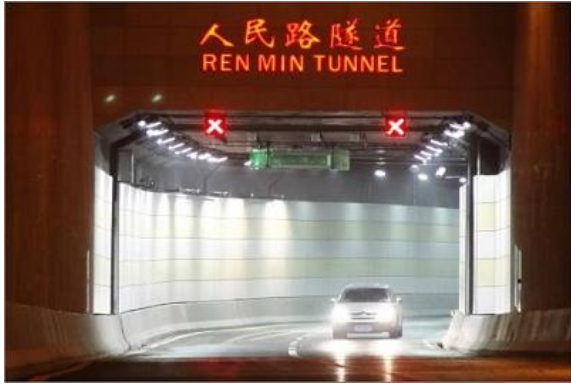
上海人民路越江隧道工程
