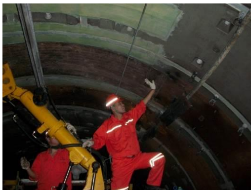
上海 2 号线东延伸管片修复
