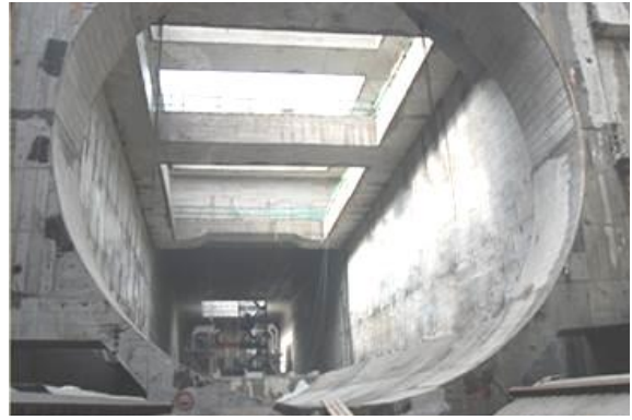
上海耀华支路越江隧道工程（磁浮）
