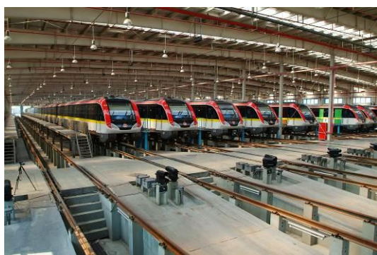
上海轨道交通 1 号线莘庄综合基地
