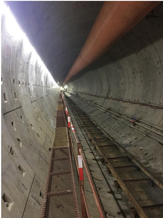
青岛地铁8号线6标（过海段）
